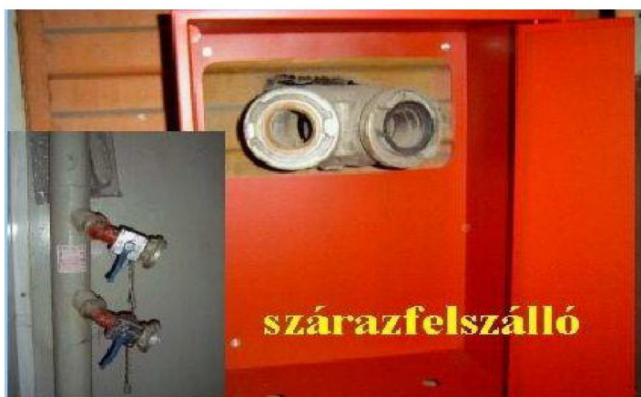
1. számú kép. Száraz felszálló. Készítette: Mazák Viktor 2010.
